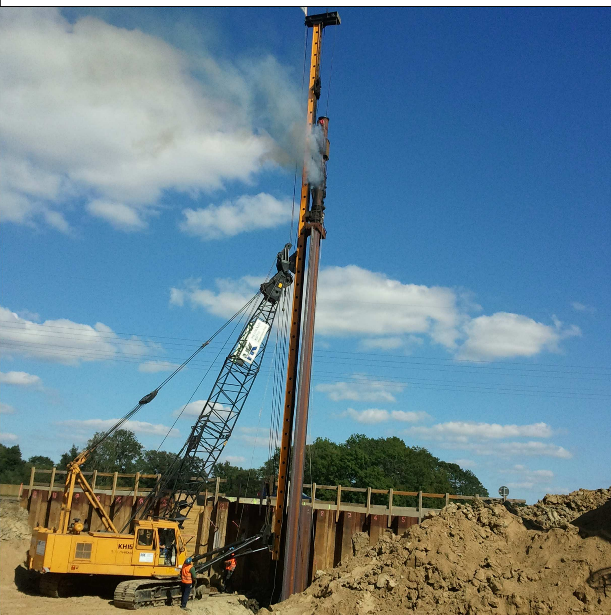
Rammeinheit konventionelle Rammung, Seilbagger mit Mäkler und Delmag D30 Hermann Koth Ingenieurbau GmbH & Co.KG
