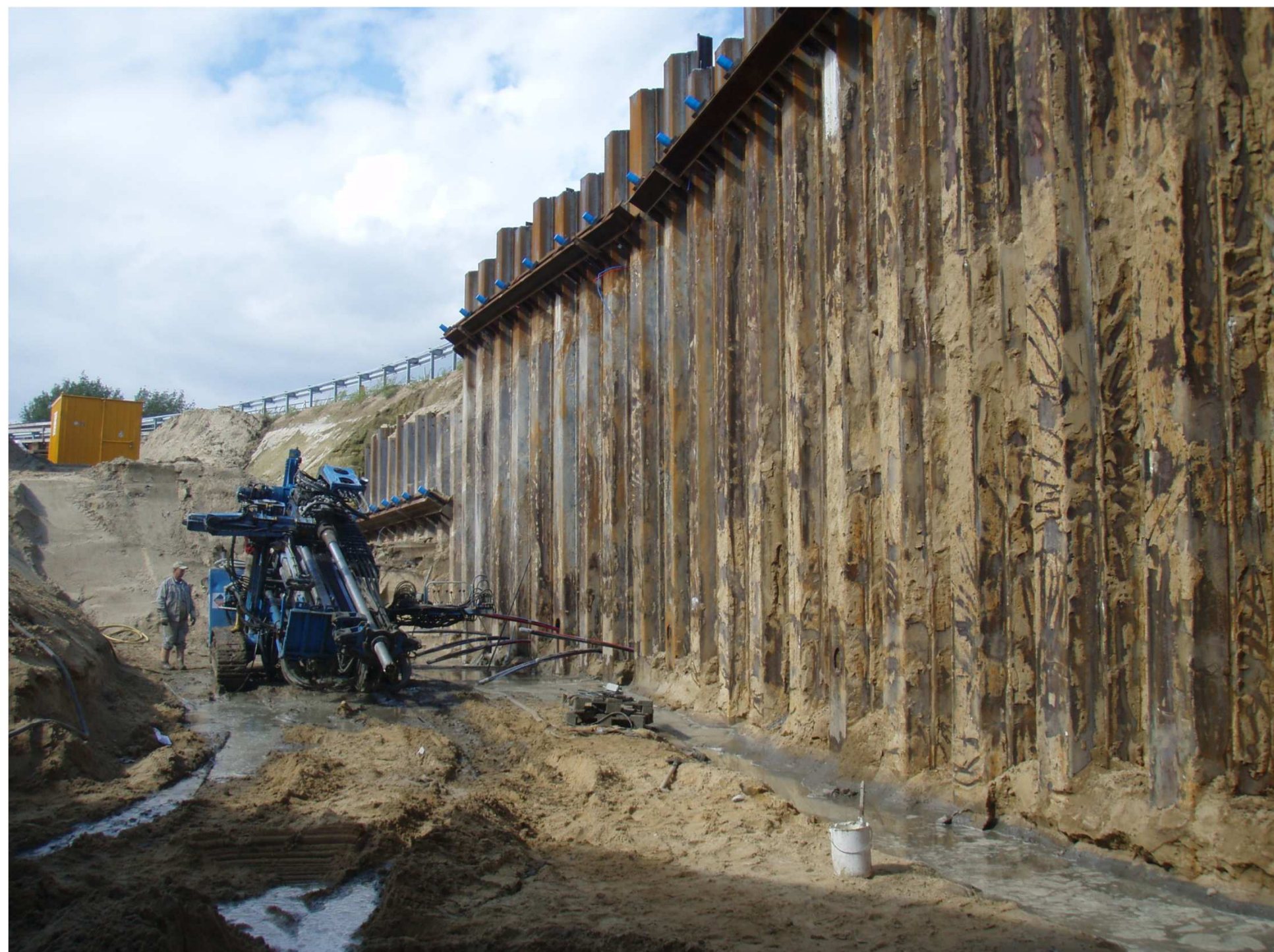
Spundwand mit Rückverankerung, ca. 7,0m Höhe, Hermann Koth Ingenieurbau GmbH & Co.KG
