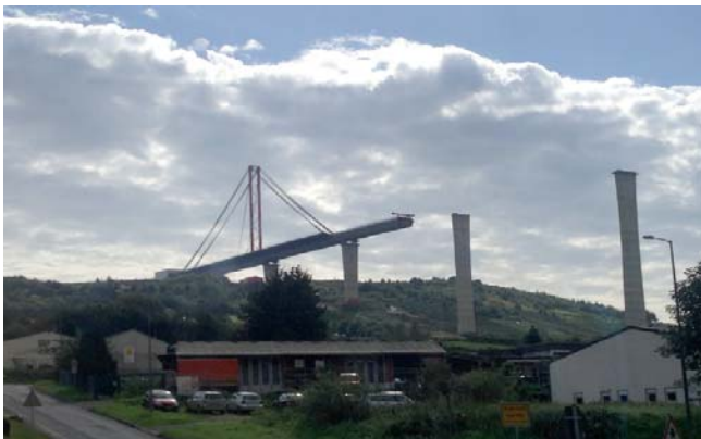
Hochmoselbrücke im Bau
