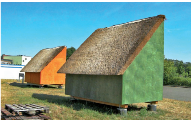
Abb. 9: NW-Ansicht der fertigen Versuchsdächer
