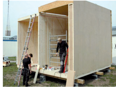
Abb. 13: Fertiger Rohbau der Raumzelle
