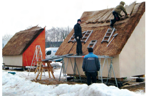
Abb. 8: Eindecken der Versuchsdächer
