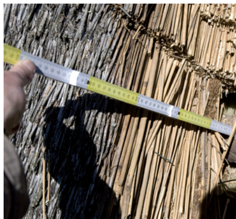
Abb. 5: Überprüfung der Eindeckdicke des Reets und der Materialbeschaffenheit
