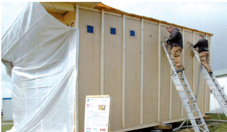
Abb. 14: Einblasen der Holzfaserdämmung
