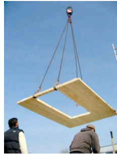
Abb. 12: Montage der Massivholzelemente der Raumzelle
