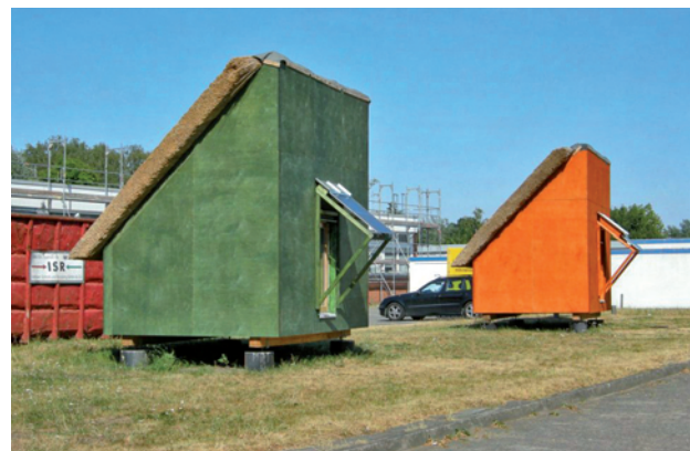
Abb. 10: SW-Ansicht der fertigen Versuchsdächer
