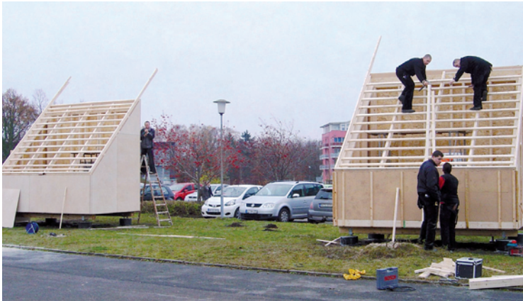
Abb. 7: Errichten der Versuchsdächer auf dem Gelände der FH Lübeck
