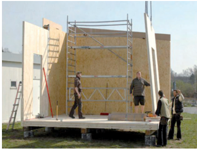
Abb. 11: Montage der Massivholzelemente der Raumzelle
