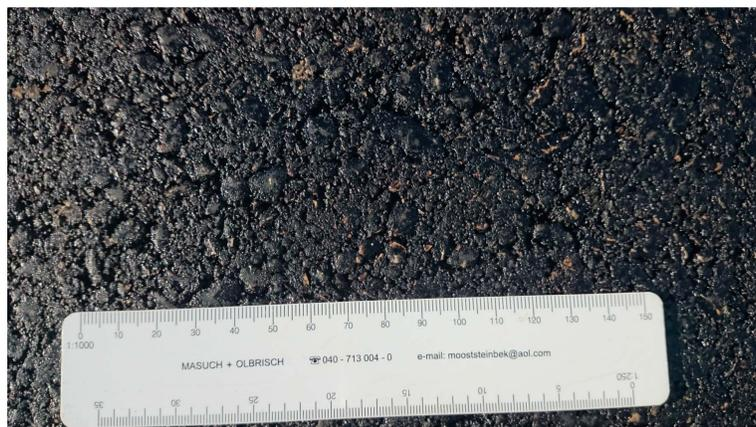
Bild 2: Mittels Gummiradwalze verdichtete Fläche
